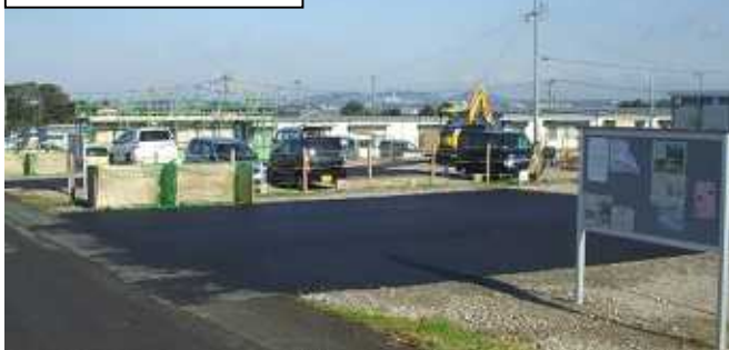
仮設住宅建築現場
